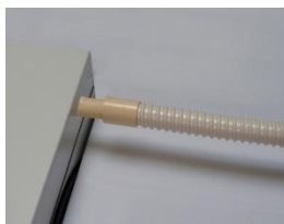
Nasunutí hadice, zajistit sponou (spona dodávka montážní firmy)
