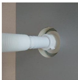
Našroubujete flexi připojení na výpust
