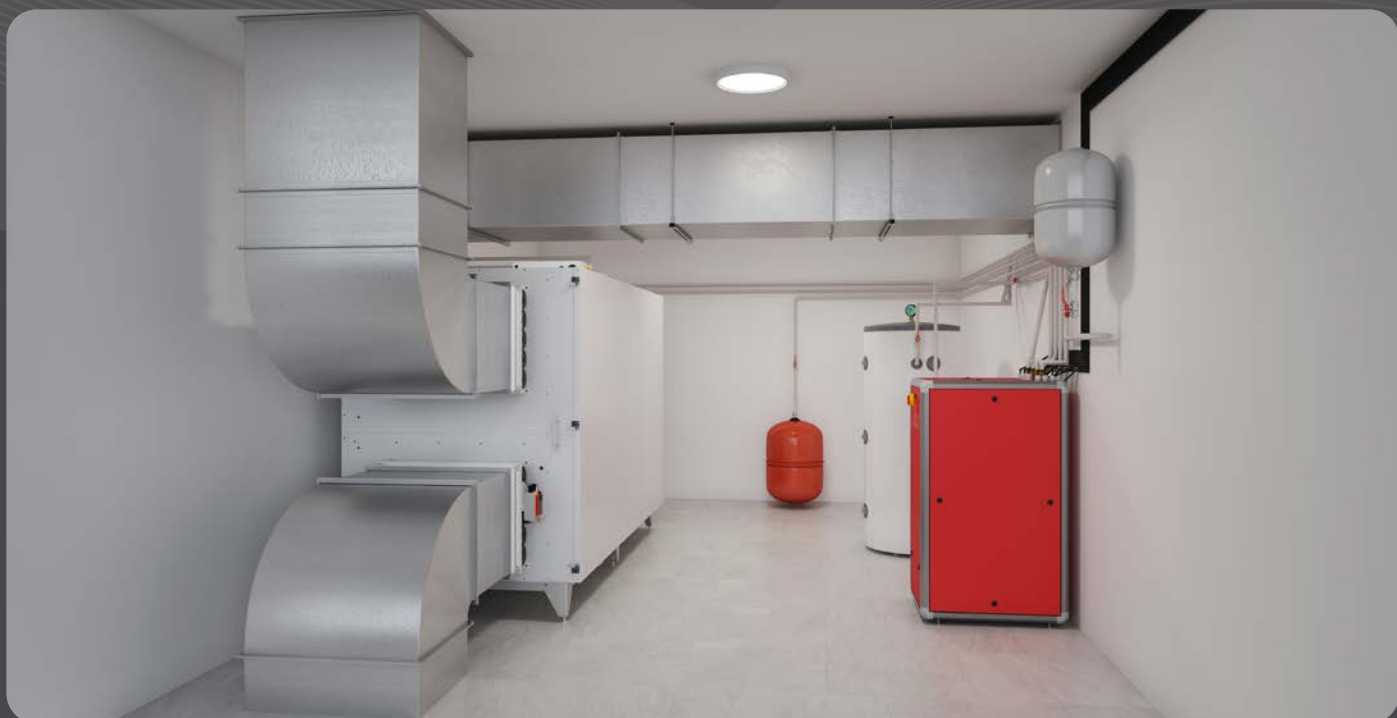
Vzorová technická miestnosť s vetracou jednotkou s rekuperáciou tepla DUPLEX Basic 15100, tepelným čerpadlom Master Therm AQ90I a akumuláčným zásobníkom tepla
