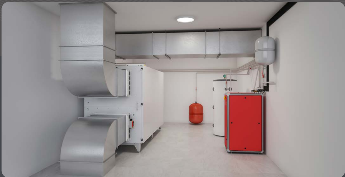
Minta műszaki helyiség DUPLEX Basic 15100 hővisszanyerővel ellátott szellőztetőegységgel, Master Therm AQ90I hőszivattyúval és hőtároló tartállyal
